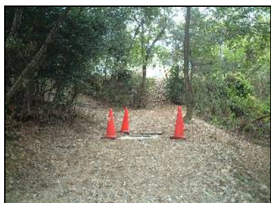
山あいの林道にピットを新設
